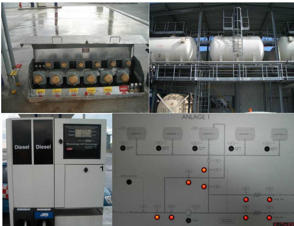
Conexión del mangueras de la estación de servicio existente (arriba izq.), granja de tanques de líquidos de deshielo (arriba der.), bomba de combustible (abajo izq.), panel de control (abajo der.)
